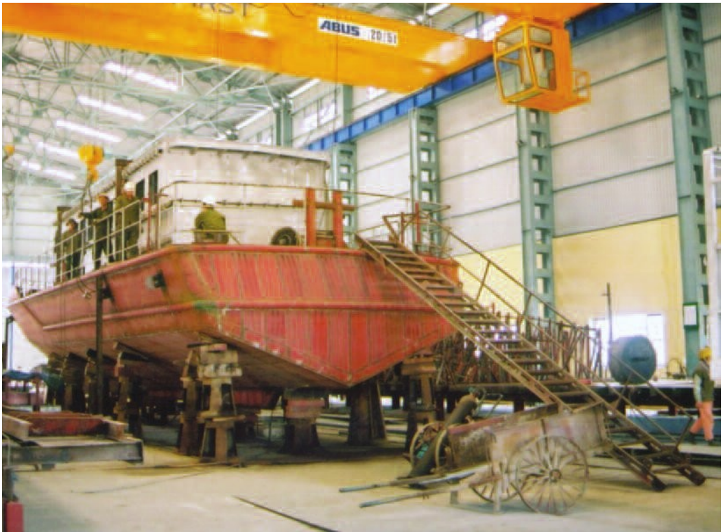
Hình 10. Xưởng sửa chữa tàu thuyền
