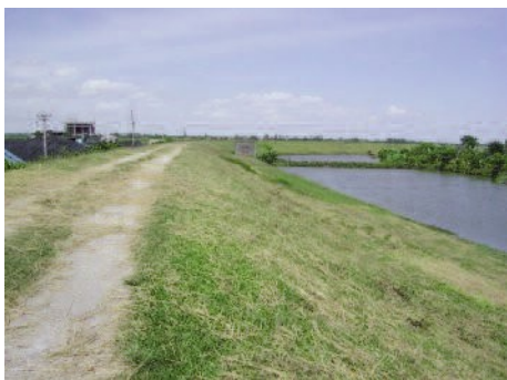
Hình 3. Một đoạn đê sông Hồng
