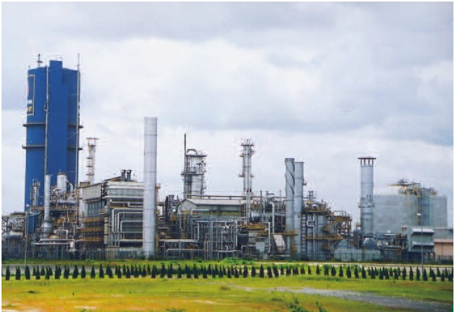
Hình 8. Nhà máy đạm Phú Mỹ
