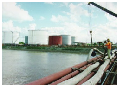
Hình 2. Đường ống dẫn vào kho chứa dầu khí
