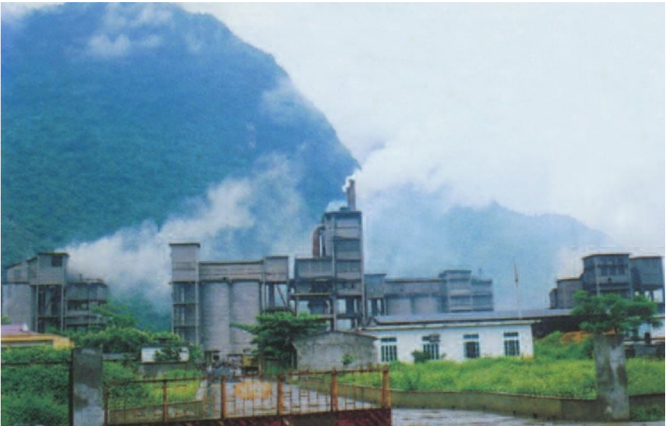
② Nhà máy xi măng Hà Giang
