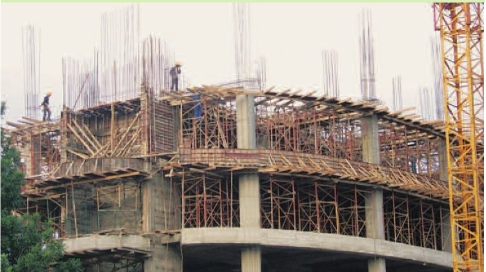
③ Đổ bê tông cốt thép
