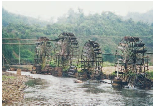
⑥ Bánh xe nước (cạn nước)
