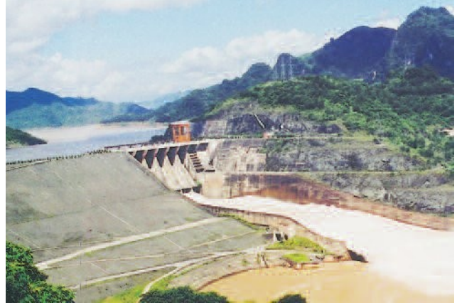
④ Nhà máy thủy điện
