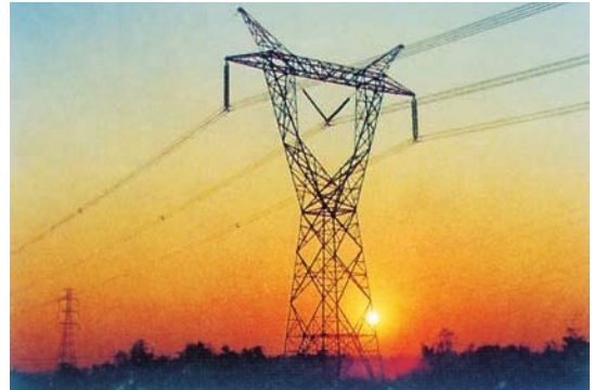
Hình 32.4. Đường dây truyền tải điện cao áp
