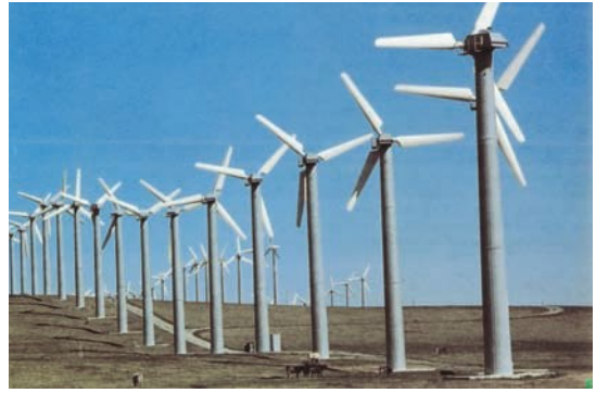
Hình 32.3. Trạm phát điện năng lượng gió
