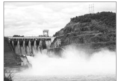
Hình 17.3 Đập thủy điện Hoà Bình.
