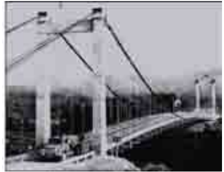
Cầu treo Bình Thành trên tuyến quốc lộ 19 nối thành phố Huế với huyện miền núi A-l ới. nh VNTTX.
