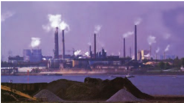
Hình 44 - Sự tập trung công nghiệp bên sông Rai-ơ (CHLB Đức)
