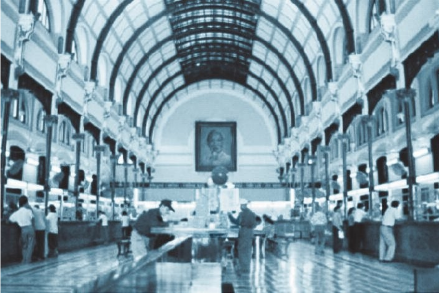
La charpente métallique de la Poste centrale de Hô Chi Minh-Ville a été conçue par Gustave Eiffel.
