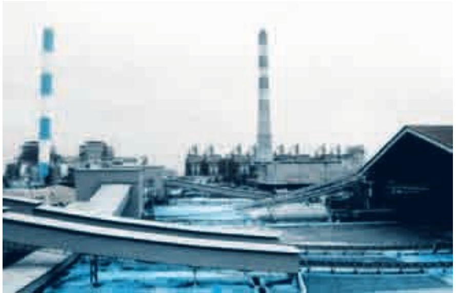
Nhà máy nhiệt điện Phả Lại
