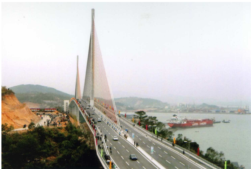
Cầu Bãi Cháy bắc qua eo biển Cửa Lục (thành phố Hạ Long – Quảng Ninh) nằm trên trục giao thông huyết mạch của vùng kinh tế trọng điểm phía Bắc.
