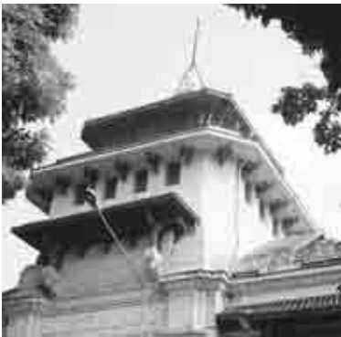
Hình 22.6 Cột chống sét.
