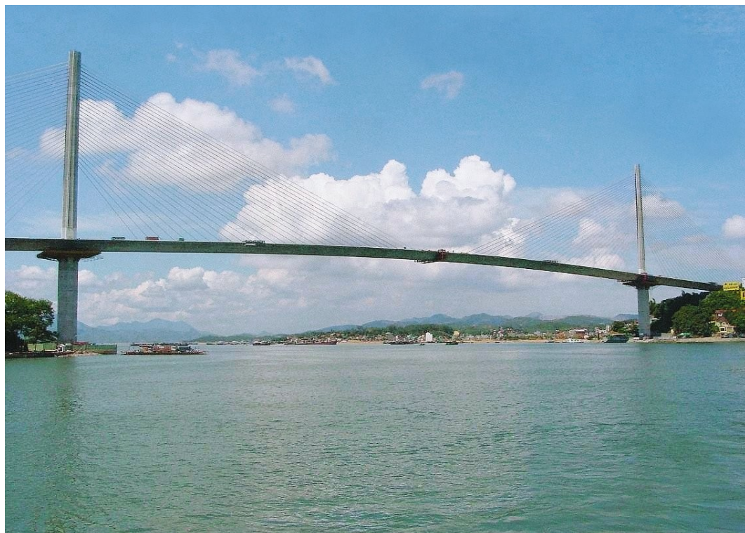
Cầu Bãi Cháy (Quảng Ninh)
